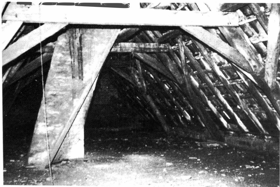
Het 17 e . eeuwse bokkespant is nog volledig intact.
