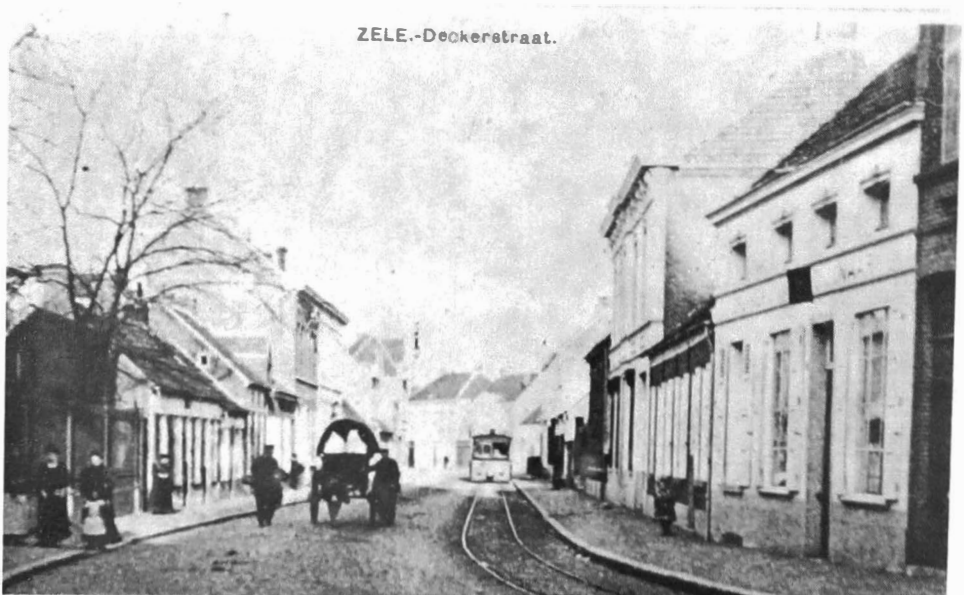
8. De licht hellende De Deckerstraat (richting Lokerenbaan), met stoomtram.
