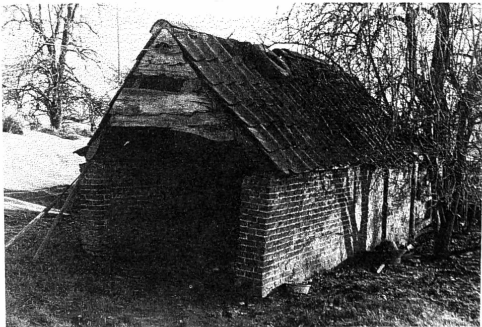
1. Een oven in een alleenstaand gebouwtje dat in de boomgaard staat bij Georges Sichien, Langevelde 46.
