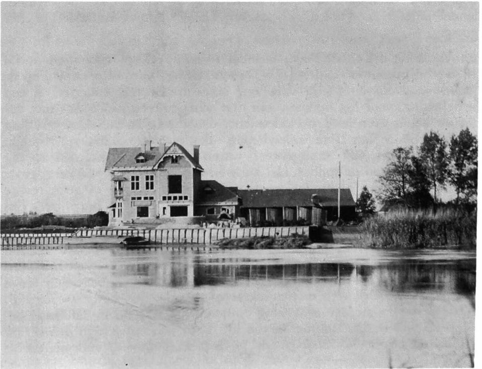
De in aanbouw zijnde villa in de volksmond "het kasteel van de Dijk" genoemd.
