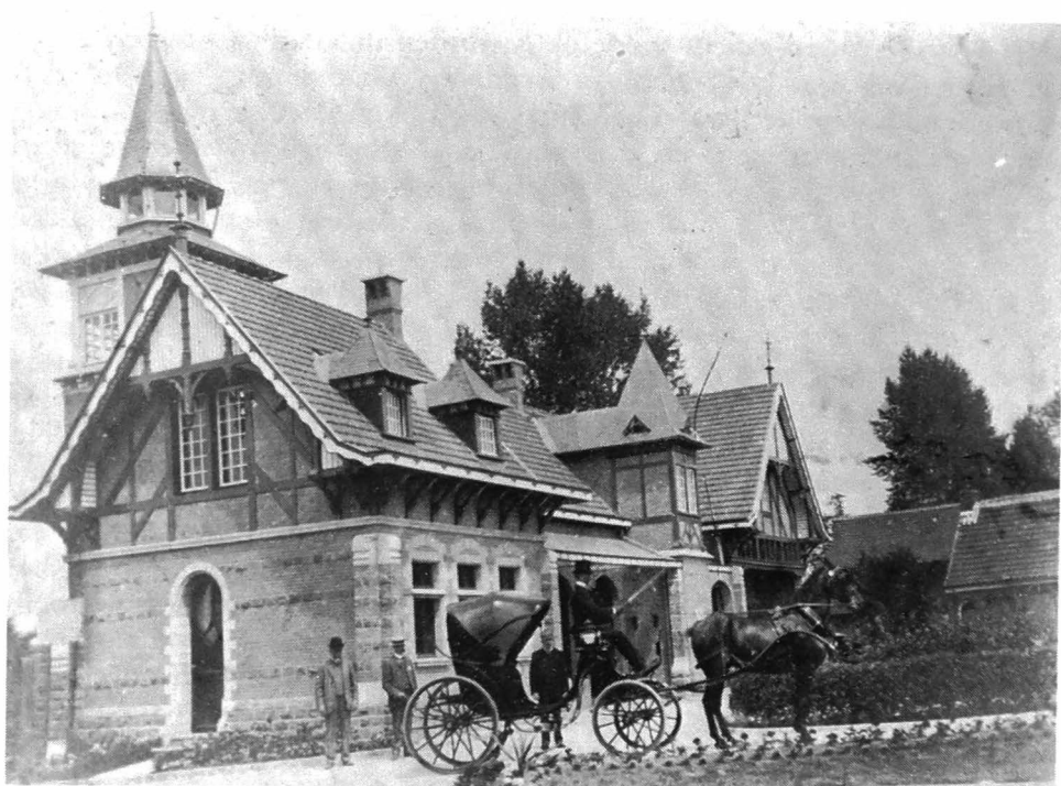
Eugène Burm (1) met een zijner rijtuigen. De in 1903 opgetrokken gebouwen langsheen de straat deden dienst als burelen, remise, paardenstallen, zadelhuis e.d.
