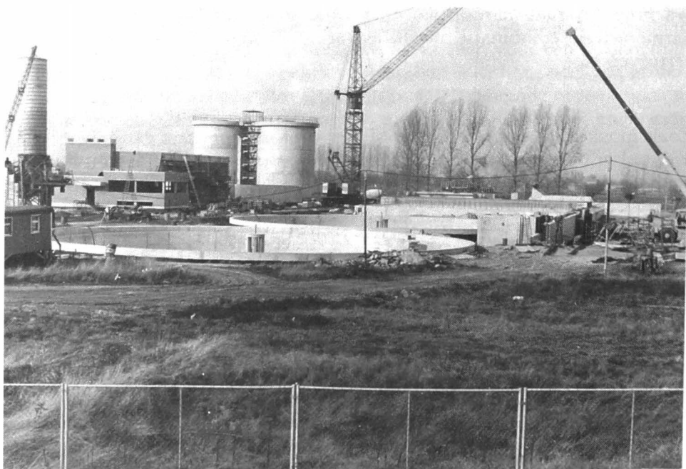
De stand der werken aan het waterzuiveringsstation, begin 1983.
