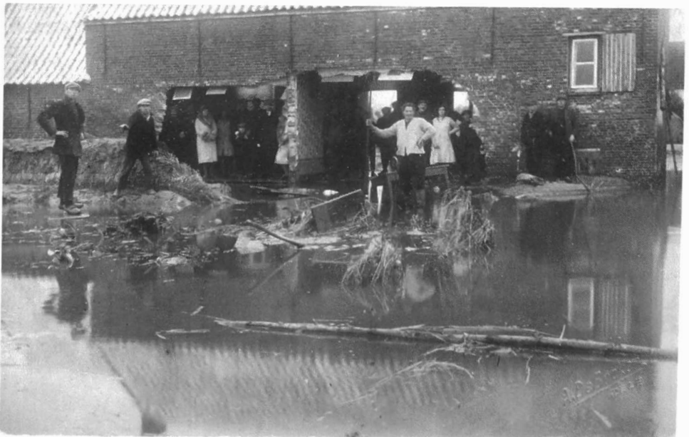
Bij de overstrooming aan 't Strooien Huisje op 23 november 1930 werd de woning van Basiel Poppe op de Kleine Dijk erg geteisterd. De achtergevel werd door de stroming weggeslagen en de inboedel dreef buiten. In de linkeropening bemerken wij Cyriel Burns, de gezusters De Backer, Basiel Poppe met kleinzoon Kamiel Burns en Jules Van Wichelen. Op de voorgrond Clemence Baetens.
