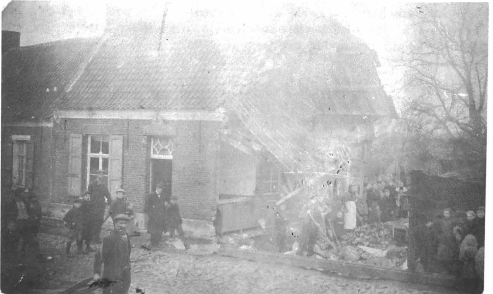
"Het Schipken" na de dijkbreek in november 1917. De opruimingswerken zijn aan de gang. De heer met de hoed is de "garde rivier" uit Gent; verder Leonard Vercauteren (met kruivagen), tussen het puin Alfons Temmerman (met schop), Desiré Verhaegen (eveneens met schop), daarachter Odile en Emeliene Temmerman (met witte schort). Ook de kinderen Isidoor, Madeleine en Clementine staan op de achtergrond.
