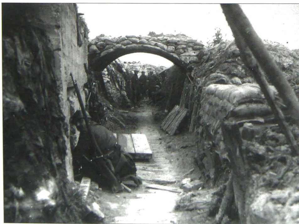
Een Belgische loopgraaf aan het IJzerfront. Men kon er evenwel niet echt graven, zodat de borstwering werd opgebouwd met zandzakjes. (verz. Fr. Huijbrechts)
