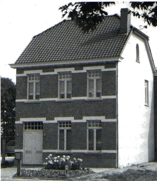
Landelijke burgerwoning uit 1930 voor "W e Verkest en kinders", langs de Gentsesteenweg. Grondig gerenoveerd in 2003 is het nog steeds een stijlvol bouwwerk.
