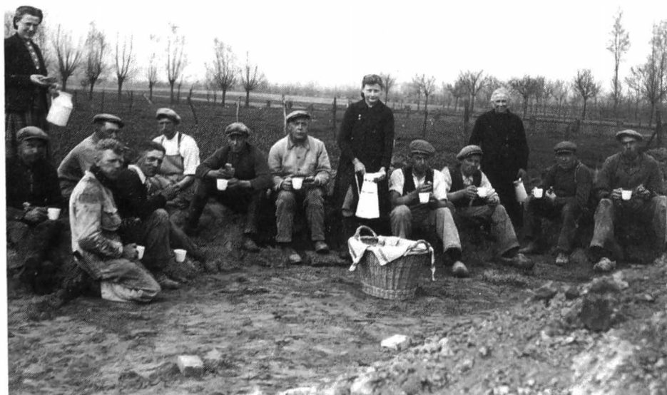
De werkzaamheden voor het bouwen van de kerk hebben een aanvang genomen. Maria Jacobs, Maria Roels en Basilia Achten zorgen voor de bevoorrading van de eerste helpers.
