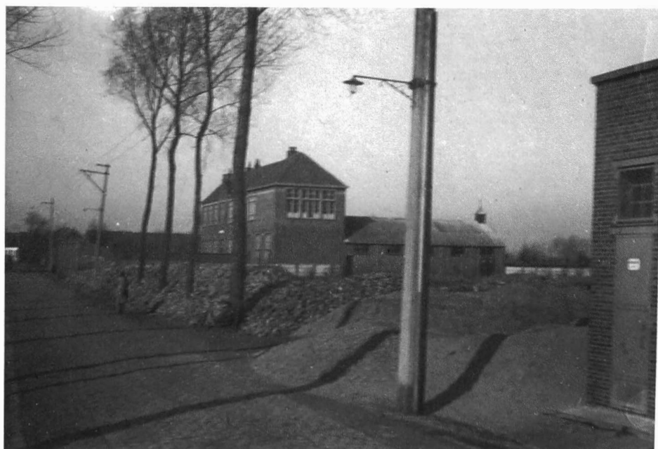
Zicht in de richting van Huivelde met school en hulpkerk.
