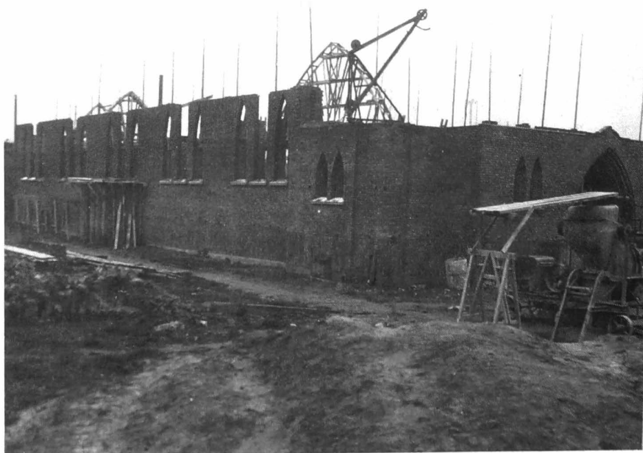
Bij gebrek aan stenen tijdens de oorlog moesten de werken worden stilgelegd. Dit verschil in stenen is nu nog duidelijk te merken vooral in de kerk zelf.
