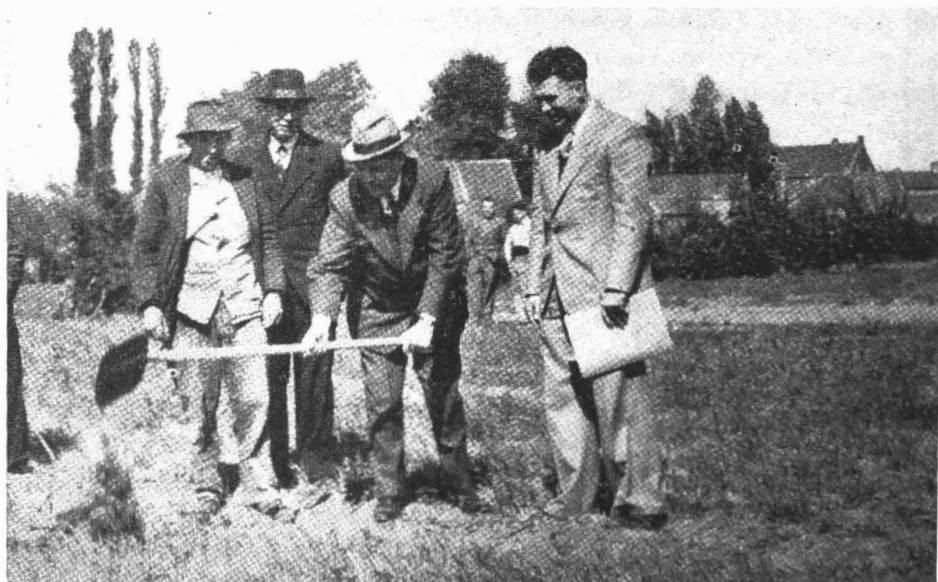
De eerste spadesteek in de zandige gronden achter de Langestraat. Op de foto de bedrijfsleider van de firma Elewaut, schepen van openbare werken Gustaaf Van Cauteren, burgemeester Van Acker en architect-urbanist Lucien Van Kerckhove uit Lokeren.
