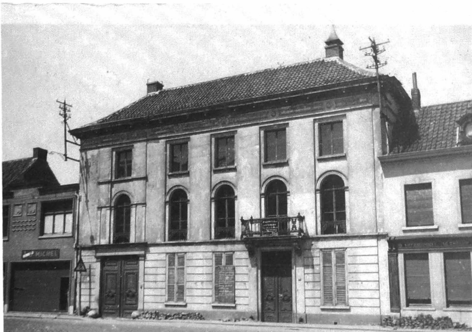
Het statige herenhuis van Maurice Caesens, met de twee arduinen bollen aan de inrijpoort, wordt eerst gesloopt.
