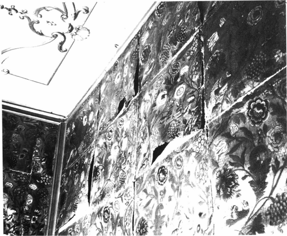
De toestand van het goudlederbehang in de dekenij vóór de restauratie.
